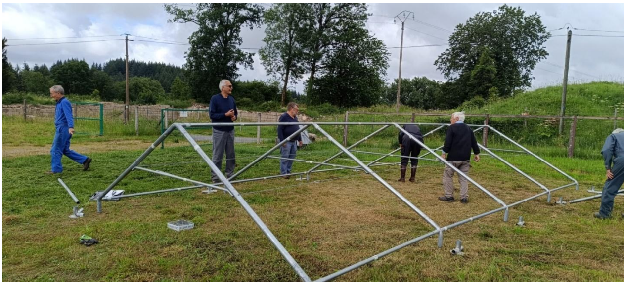
L'armature du toit est montée
