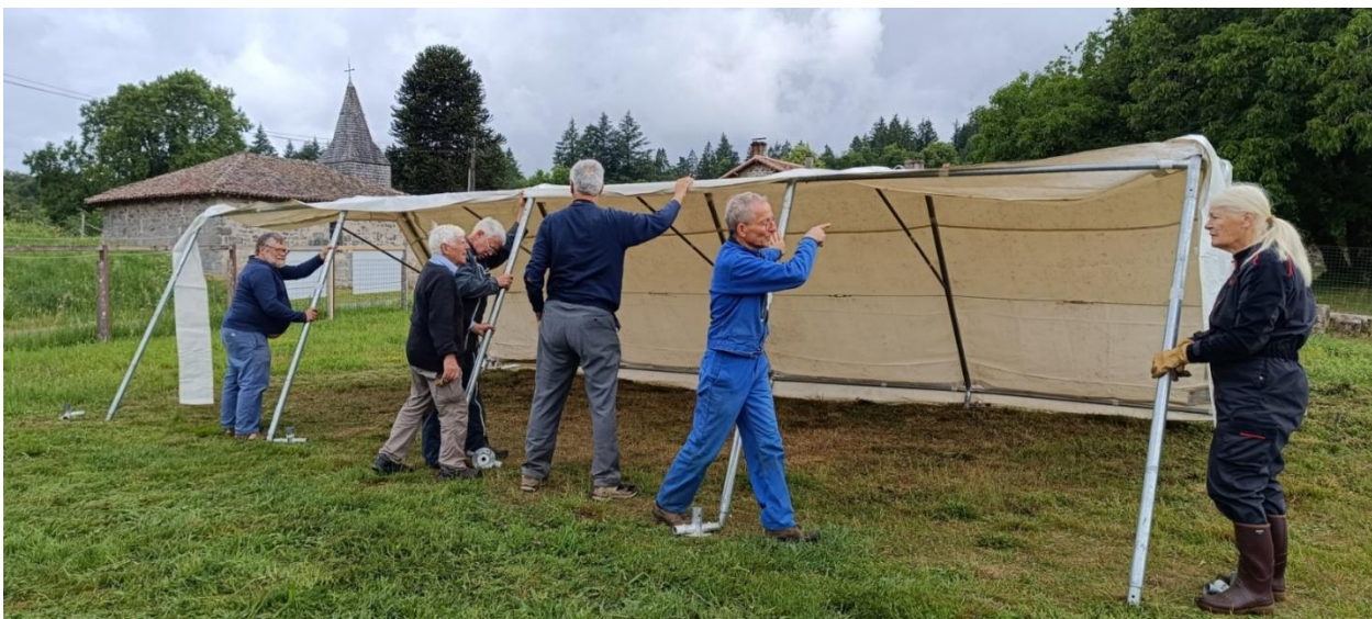
La bâche du toit est en place sur son armature
