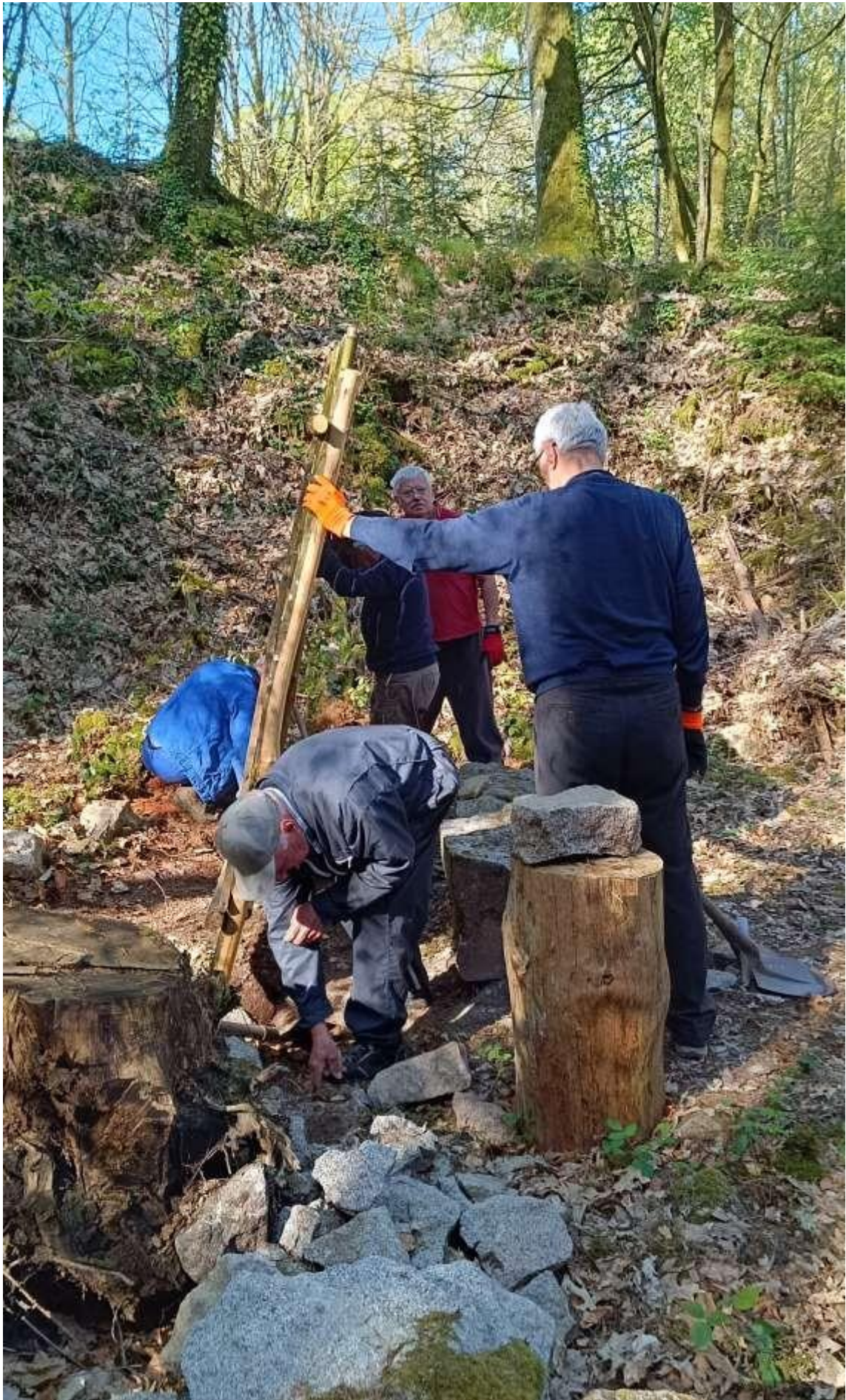
Inclinaison de l'auvent avant la fixation des montants.
