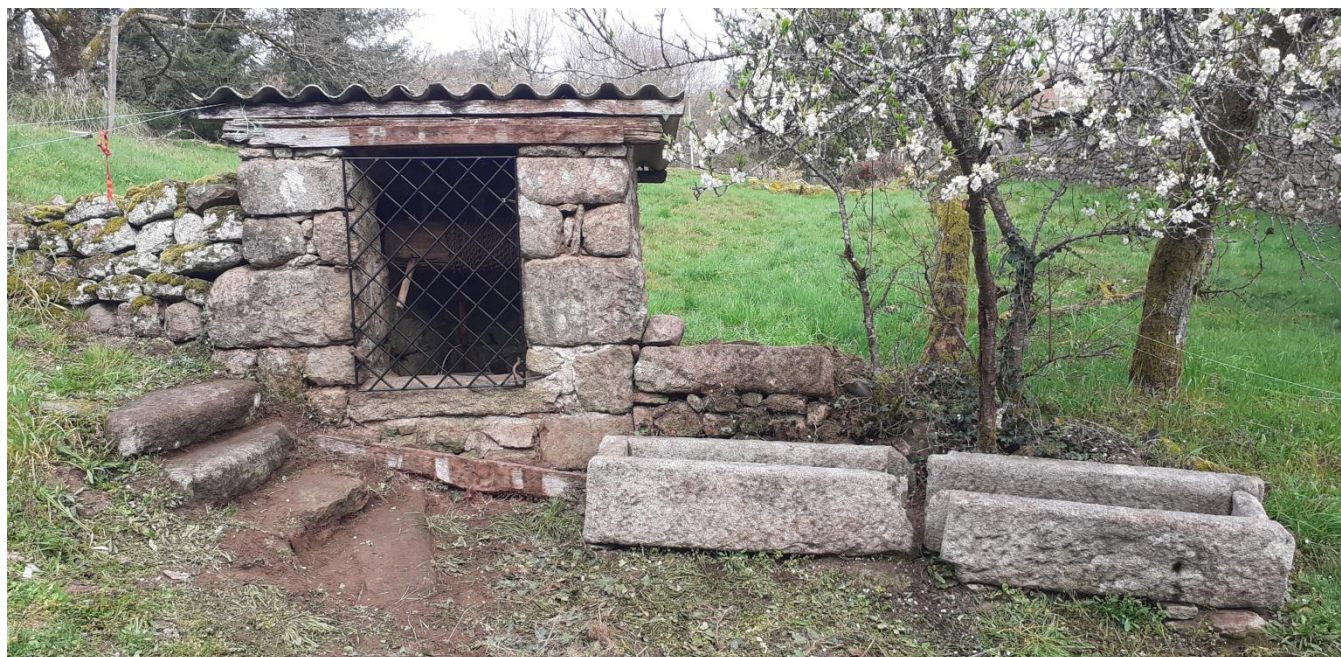
Ajout d'une grille de protection.
