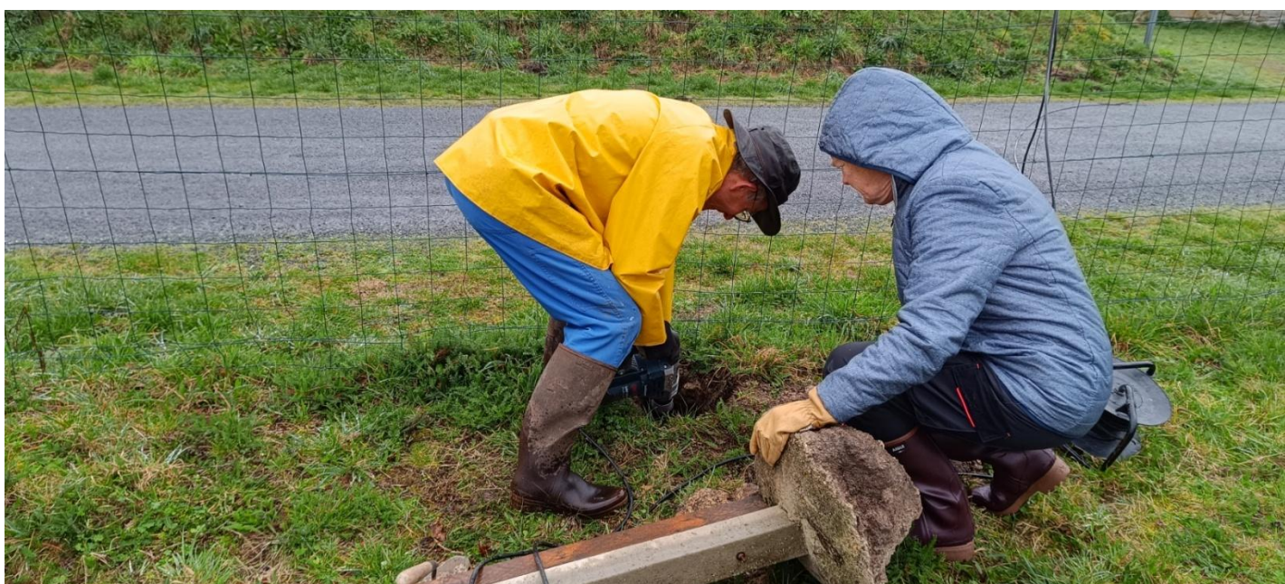
Gérard et Françoise P. enlèvent le poteau descellé à changer....
