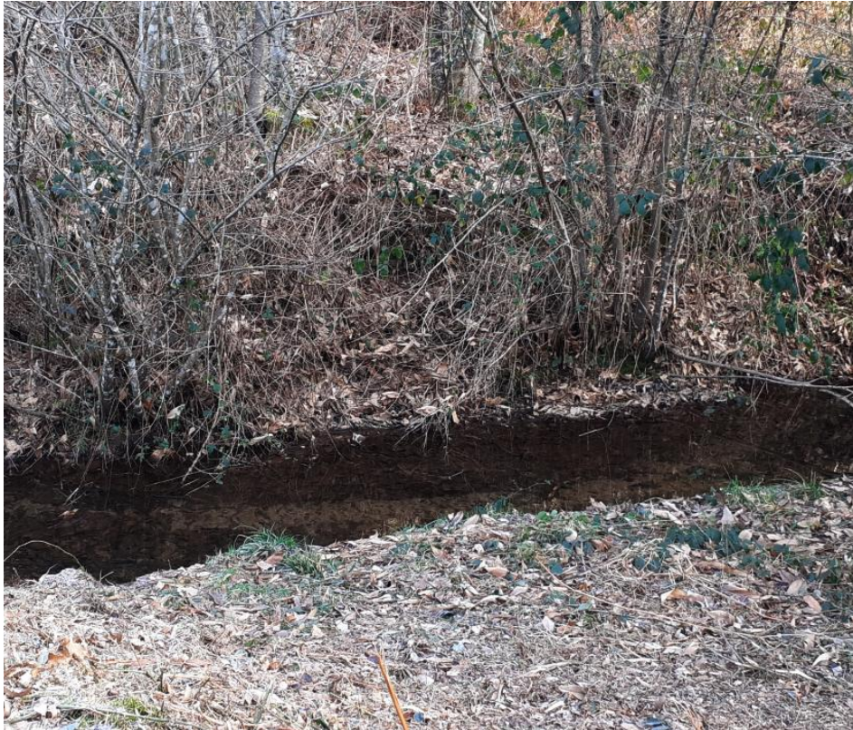
Etat avant l'intervention....
