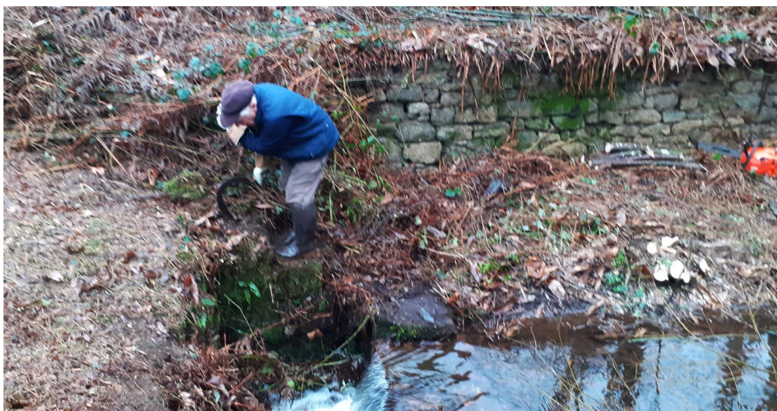
Claude Biron nettoie l'escalier menant à l'espace réservé aux lavandières.
