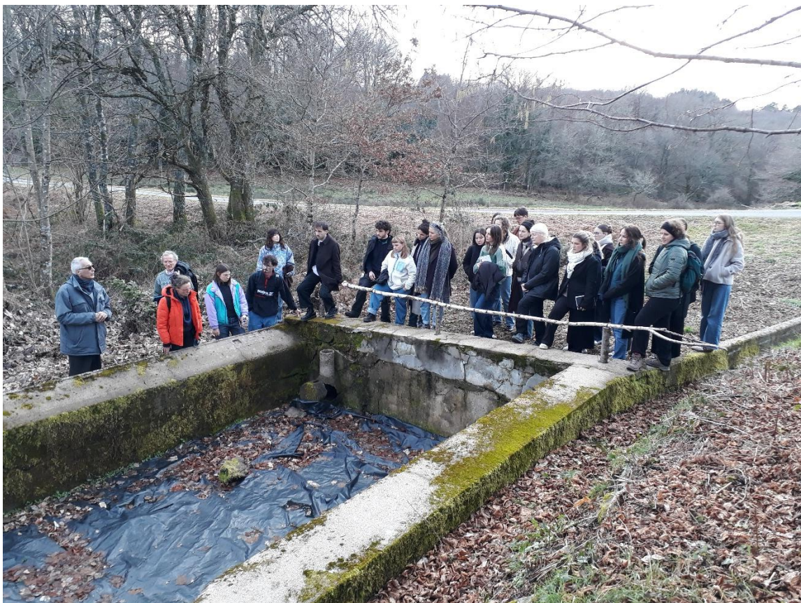
Réservoir-lavoir - Les Sagnes (1068)
