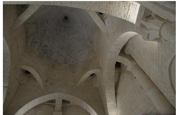
Voûte de la cuisine
