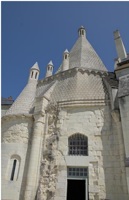
Entrée de la cuisine
