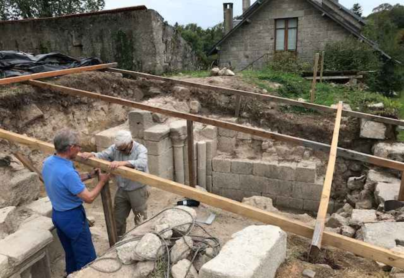
Installation du bardage de protection
