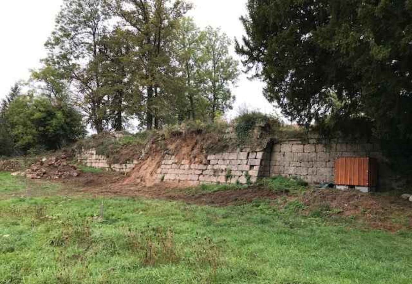
Vue générale du mur du réfectoire
