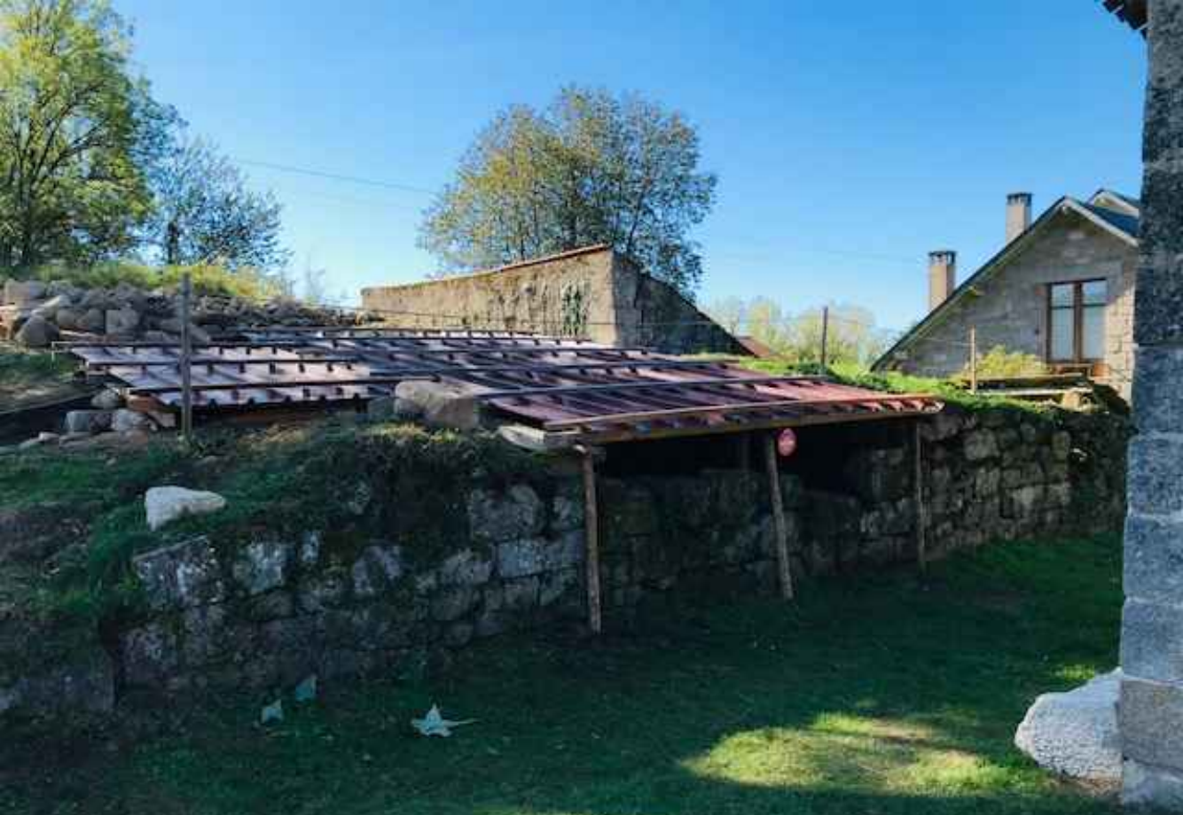
Bardage du porche d'entrée
